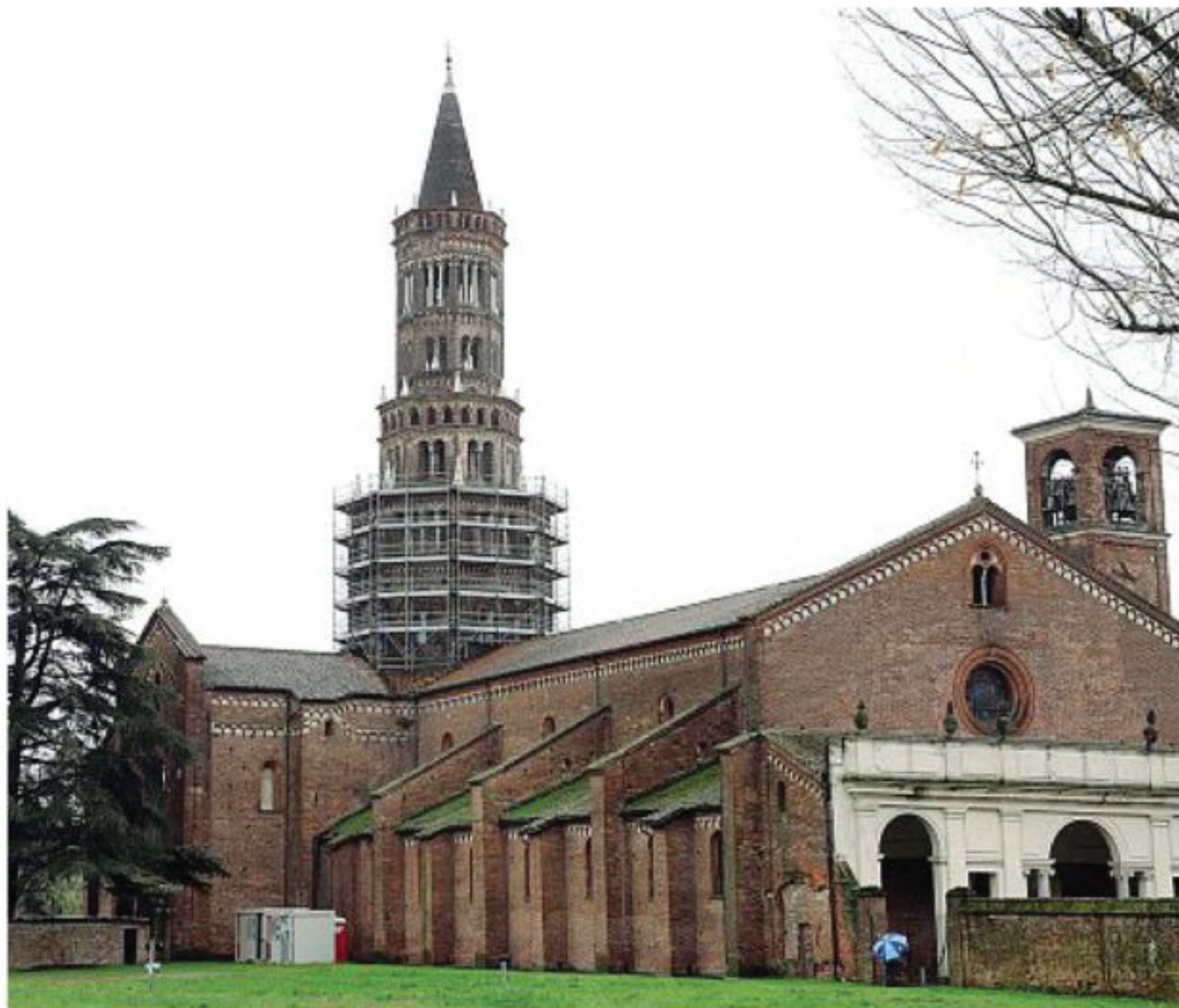
L'intervento. Sopra e sotto la ragnatela di barre d'acciaio che ora sostiene e protegge la torre campanaria dell'abbazia di Chiaravalle, a sinistra. La struttura si chiama «iperboloide parabolico» (foto Andrea Cherchi)
