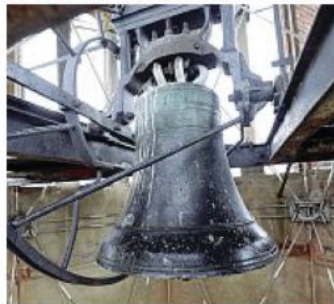
L'intervento. Sopra e sotto la ragnatela di barre d'acciaio che ora sostiene e protegge la torre campanaria dell'abbazia di Chiaravalle, a sinistra. La struttura si chiama «iperboloide parabolico» (foto Andrea Cherchi)
