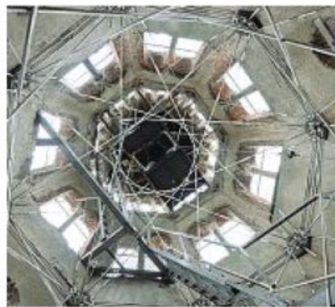
L'intervento. Sopra e sotto la ragnatela di barre d'acciaio che ora sostiene e protegge la torre campanaria dell'abbazia di Chiaravalle, a sinistra. La struttura si chiama «iperboloide parabolico» (foto Andrea Cherchi)
